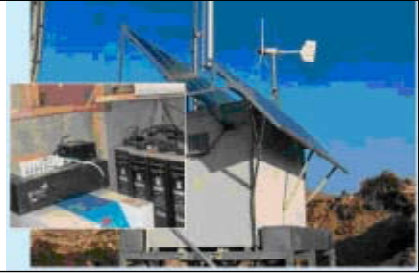
Şekil 5.10 – ÖZMAK Ltd. tarafından Çeşme-İzmir'de telekomünikasyon sistemi için yapılmış bir hibrit fotovoltaik-rüzgar uygulaması
