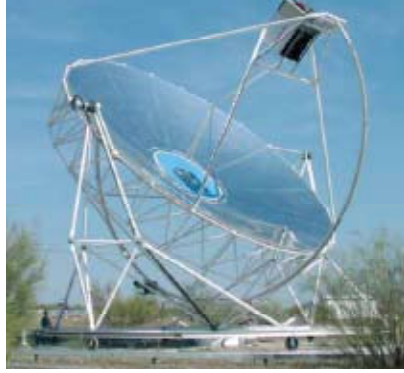
Şekil 2.18. Stirling destekli çanak kolektör
